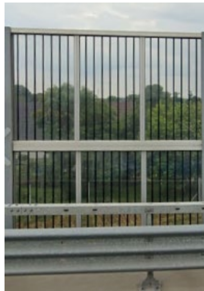
Рисунок 1 – Загальний вид шумопоглинаючої (а) та жорсткої (б) панелей [7, 8]
